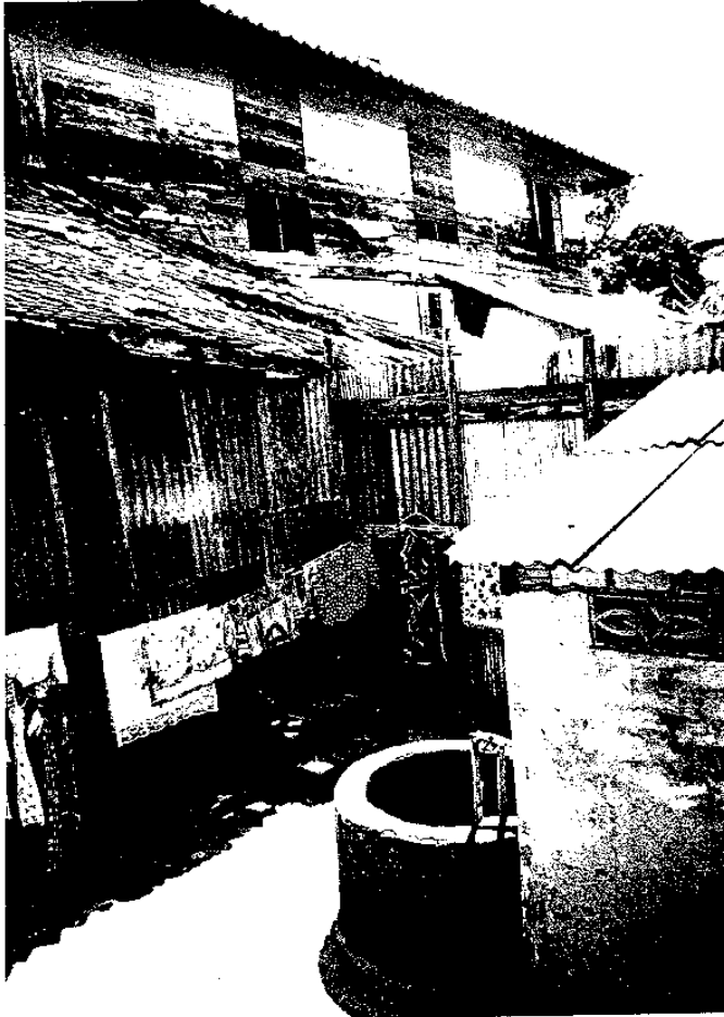
ด้านหลังเรือนพื้นที่ระหว่างห้องครัว ของเรือนเจ้าเมืองกับเรือนพัก เครื่องญาติสองชั้น เป็นลานโล่ง มีบ่อน้ำ 1 บ่อ
