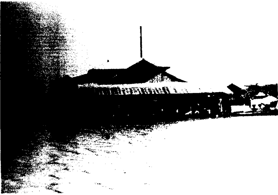
ภาพที่ 2 โรงสีเอี่ยมเส็ง (โรงสี 1 ตั้งอยู่บนฝั่งขวาของแม่น้ำปากพนัง (นับจากปากน้ำขึ้นไปยังต้นน้ำ) อยู่ในเขตเทศบาลอำเภอปากพนัง ปล่องโรงสีเป็นเหล็ก ภายหลังเกิดไฟไหม้ในปี พ.ศ. 2490 จึงได้เปลี่ยน เป็นปล่องก่อด้วยอิฐ ภาพนี้ถ่ายในระหว่างเกิดสงครามโลกครั้งที่ 2
